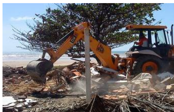
Figura 09: Demolição do Bar do Joca Fonte: emsergipe.globo.com
