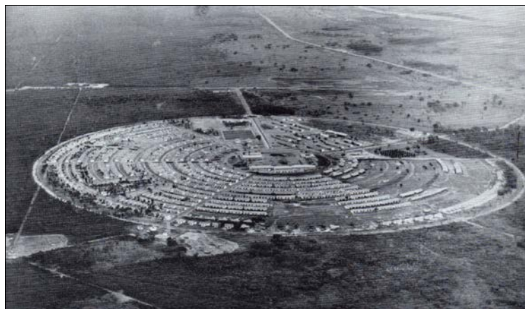
Figura 02: Vista aérea da Vila Piloto. Fonte: Planejamento..., 1962, p.03.
