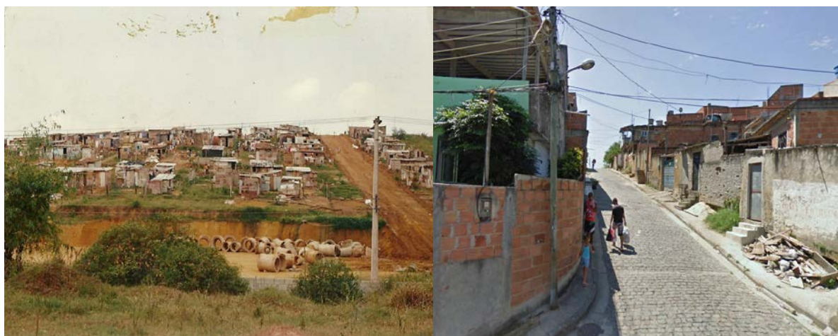
Figuras 3 - Vinte anos separam a fase inicial das ocupações e a implantação de infraestrutura que consolidou mais um bairro na região de Anchieta. Fonte: Arquivo Paulo de Aquino e site Google Maps.
