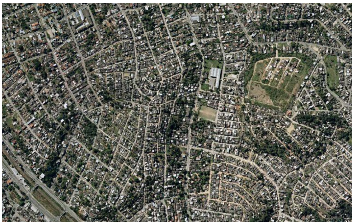
Figura 4 – Anchieta, no Rio de Janeiro: como distinguir o bairro formal daquele gerado pelo movimento de ocupação liderado por Paulo Aquino? Fonte: site Google Maps.
