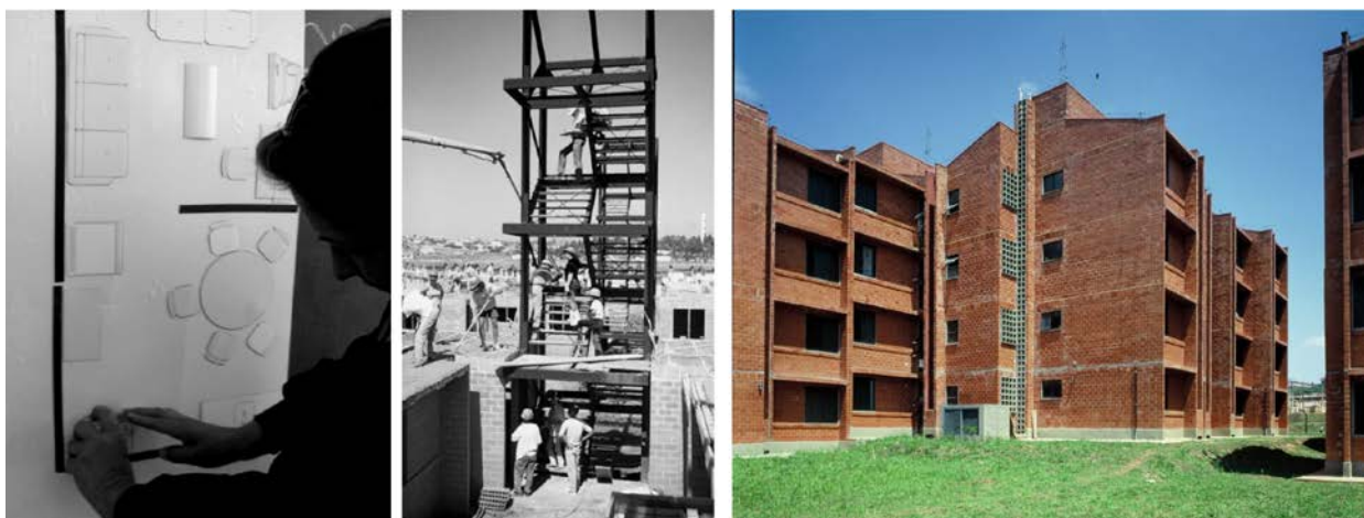
Figura 2 - População tem a oportunidade de mudar e refazer o projeto | Inovação tecnológica: as escadas metálicas são colocadas na mesma etapa que são feitas as fundações | Vista geral do conjunto - fonte: www.usinactah.org.br
