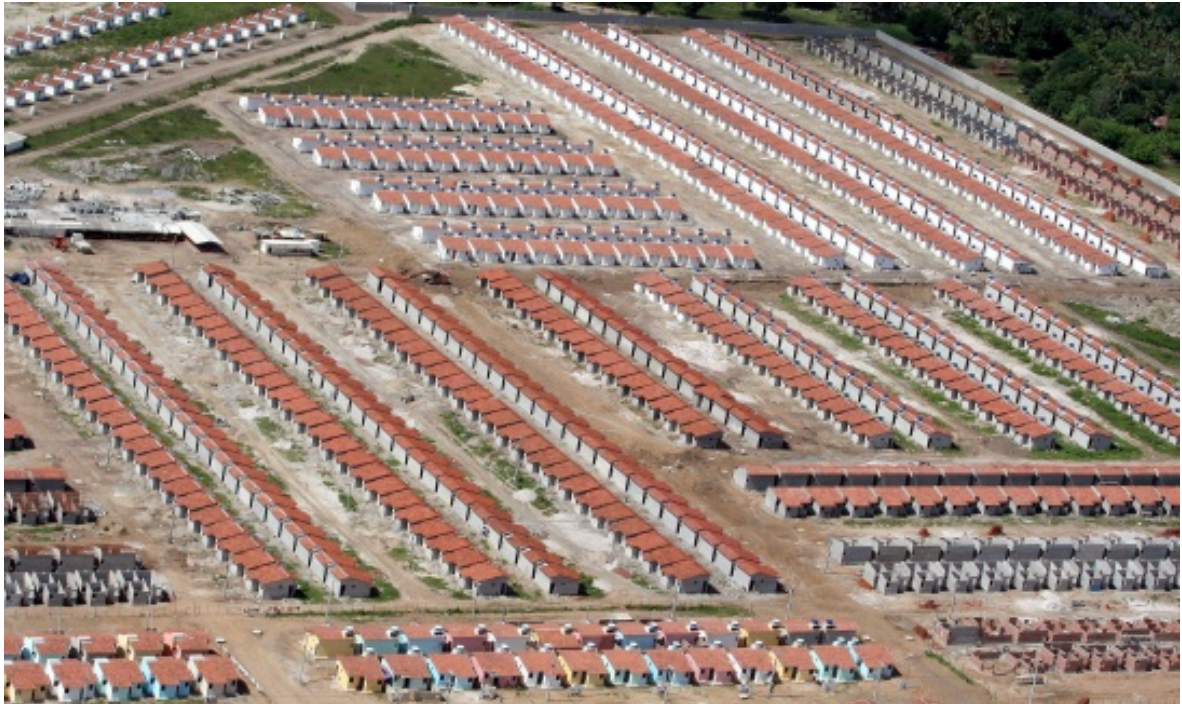
Figura 2: Conjunto Habitacional Gervásio Maia, João Pessoa – PB, 2010
