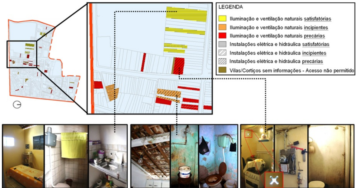
Figura 03: Situação interna das habitações – Iluminação e ventilação naturais e instalações elétrica e hidráulica. Fonte: Base digitalizada da PMJP – Prefeitura Municipal de João Pessoa – modificada por Camila Coelho.
