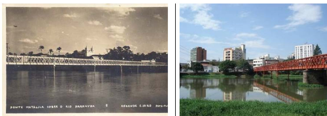
Ponte Metálica Nilo Peçanha. Acervo Prefeitura Municipal de Resende e Ponte Metálica em 2012. Foto: Andréa Auad, 2007.
