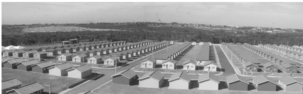
Figura 8: Conjuntos José Carlos Guimarães I e II com 900 unidades e ao fundo conjunto Júlio Campos I e II, com 680 unidades, construído pelo PAR. Fonte: NavegadorMT.
