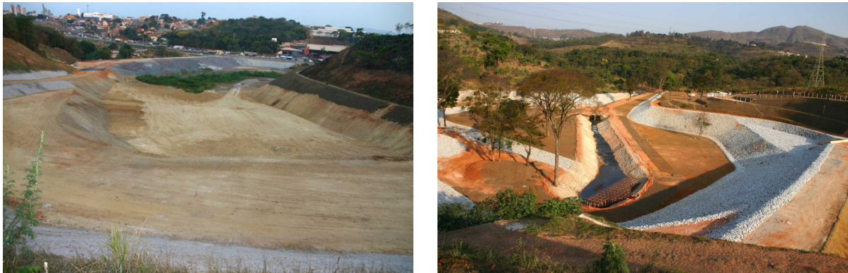
Figura 3: Bacias de retenção do final da primeira fase do DRENURBS: córregos Engenho Nogueira e Bonsucesso.
