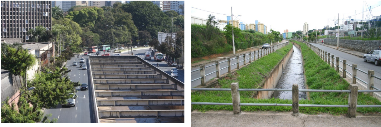
Figura 4. Tamponamento e canalização de rios urbanos como práticas recorrentes: expansão do Boulevard Arrudas na Área Central de Belo Horizonte e canalização do córrego S. Francisco no bairro Liberdade.
