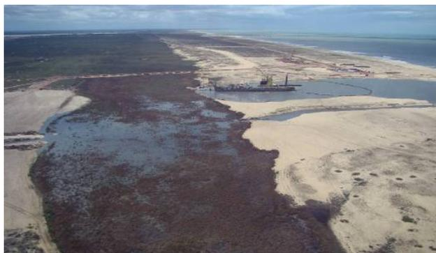
Figura 04 – Dragagem do canal de acesso ao terminal TX-2.
