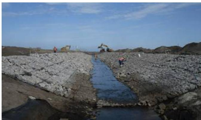
Figura 02- Canal de drenagem: estaleiro da OSX.
