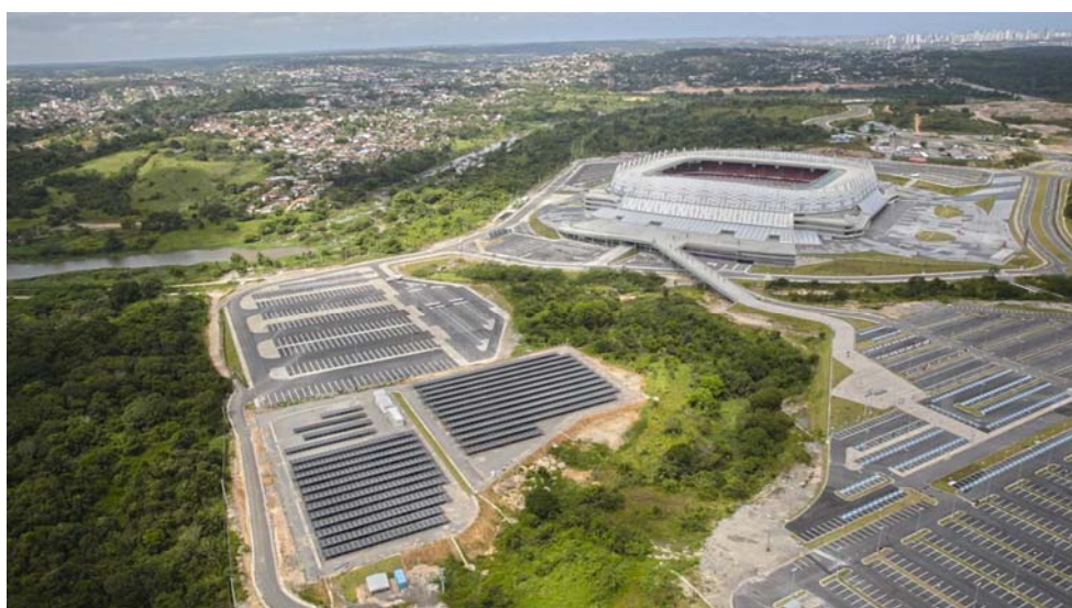
Arena Pernambuco, viaduto construído, estacionamentos e tecido urbano circundante. Foto: Brasil Engenharia, 2014.
