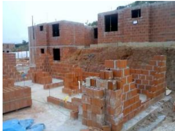
Figura 2 - Residencial Rio das Velhas II, Ipatinga (Minha Casa Minha Vida - Entidades em execução).
