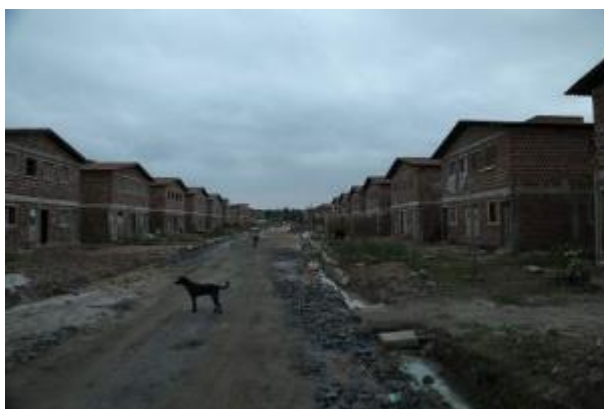
Figura 5 – Empreendimento Nossa Prata, etapa construído pela Prefeitura de Paulista. Crédito:
