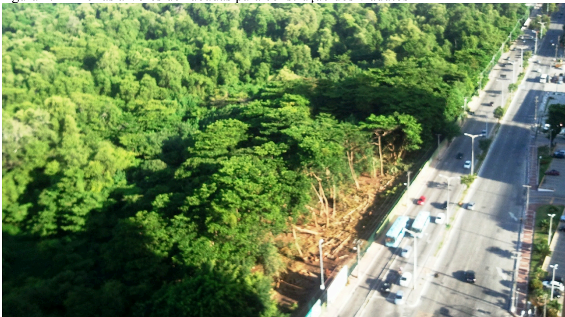
Figura 4. Primeiras árvores derrubadas para construção dos viadutos
