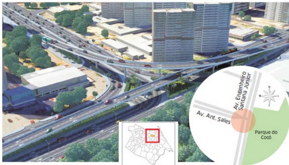
Figura 3. Viadutos do Cocó
