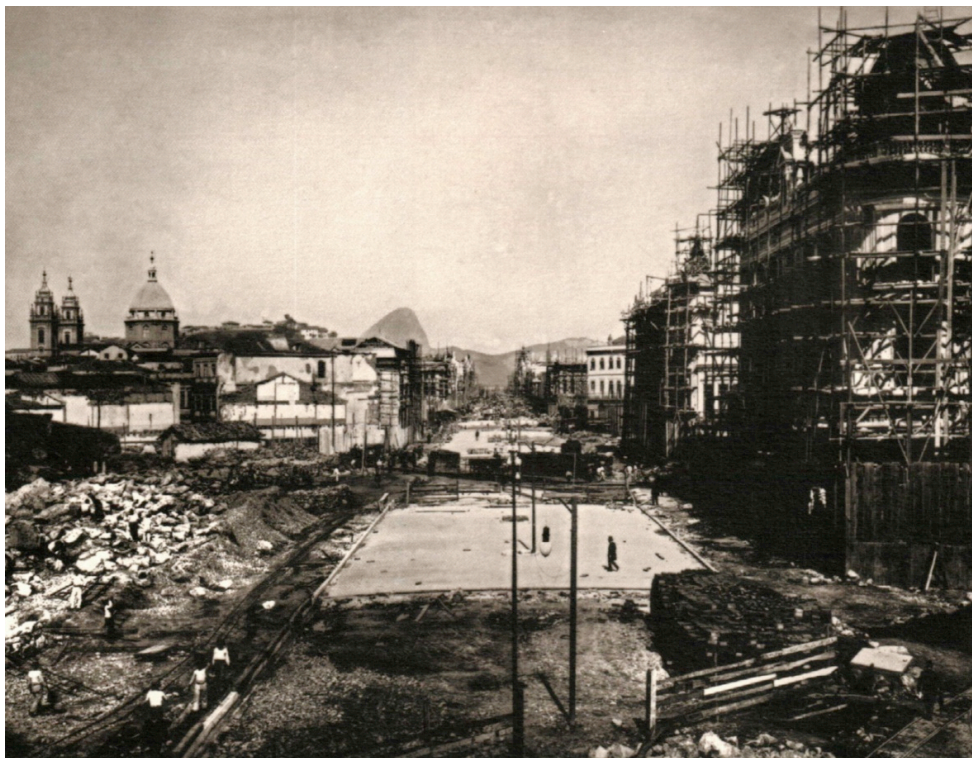
Figura 4: Construção da Av. Central, por Augusto Malta.
