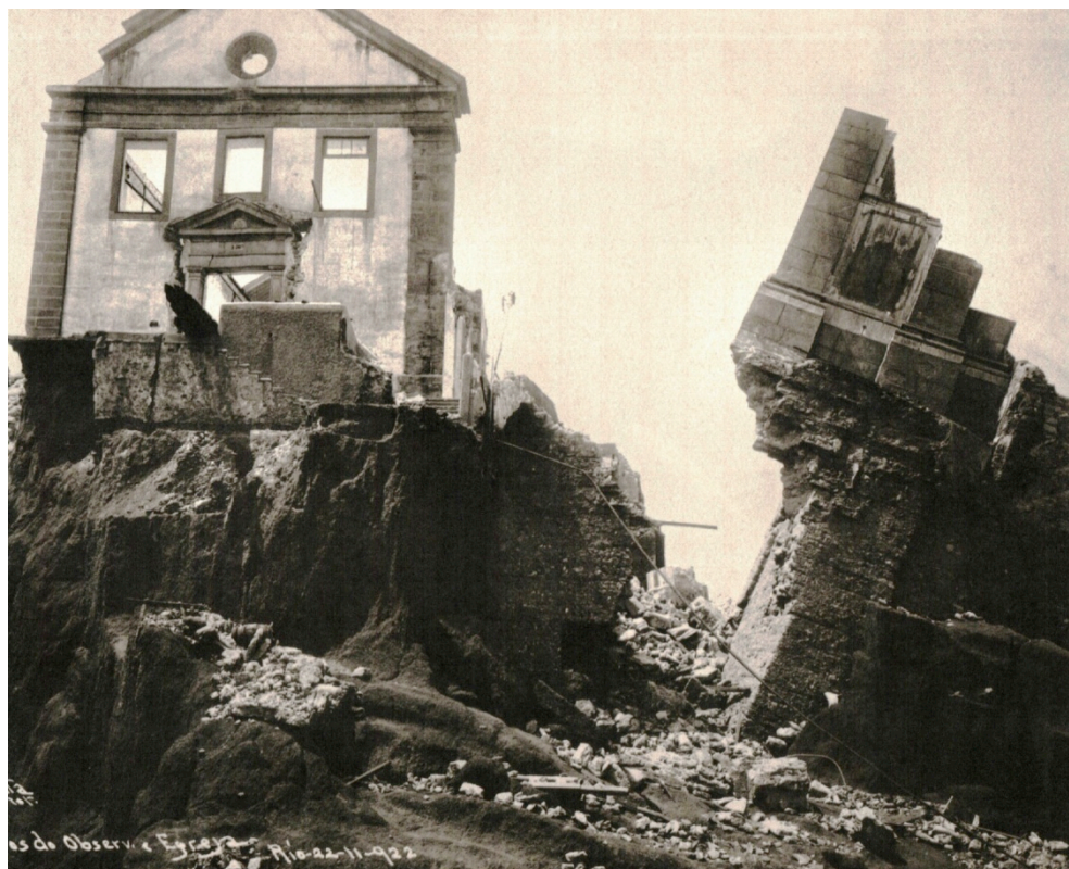
Figura 6: Demolição da igreja e observatório do Morro do Castelo, 1922, por Augusto Malta. Fonte: ERMANKOFF, G 2009, Augusto Malta e o Rio de Janeiro: 1903-1936 , 2ª ed, Rio de Janeiro, G. Ermankoff Casa Editorial, p 145.
