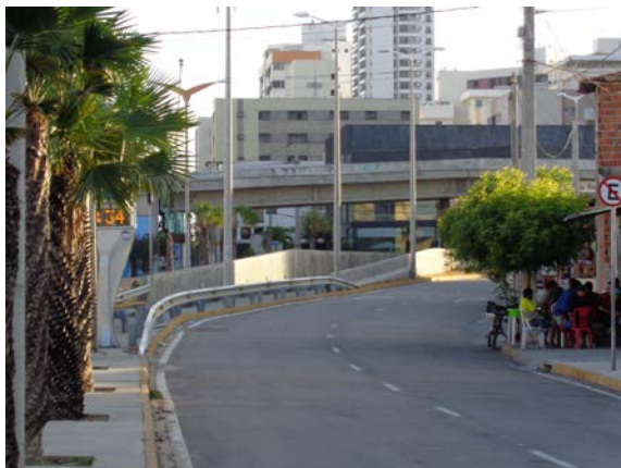
Foto do viaduto/túnel construído pela OUC e seu caráter rodoviário. Fonte: Acervo pessoal.
