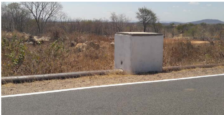
Figura 06 – Adutora emergencial de engate rápido Santa Cruz/RN – Pau dos Ferros/RN Fonte: Autoria própria, 2016.
