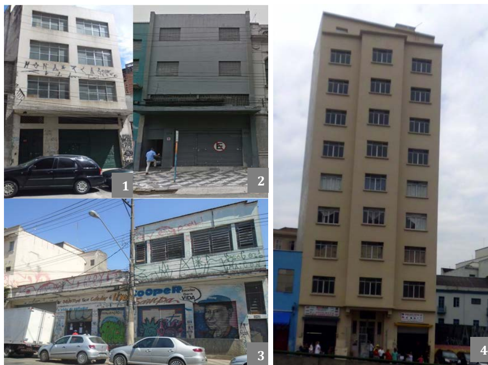
Figura 4| Alguns Imóveis não utilizados notificados que cumpriram a obrigação
