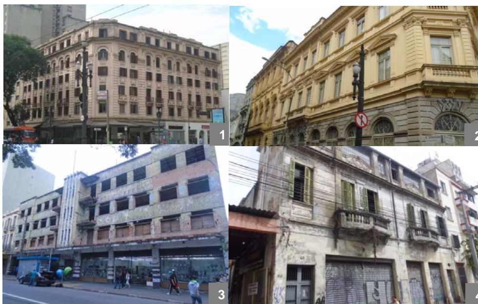
Figura 2 | Imóveis não utilizados notificados com até 6 pavimentos
