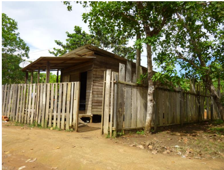
Figura 5 – Deficiências na área urbana da cidade de Ferreira Gomes.
