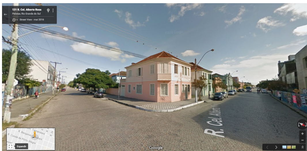
Figura 1 - Vista percurso das ruas Alberto Rosa e Benjamin Constant, Bairro Porto - Pelotas-RS
