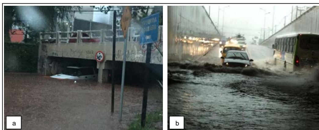
FIGURA 3 - Alagamento no pequeno viaduto entre o Flamboyant e o Jardim Goiás, por baixo da Avenida Jamel Cecílio (a) e alagamento no Viaduto da Avenida 85 (b) em Goiânia - GO.
