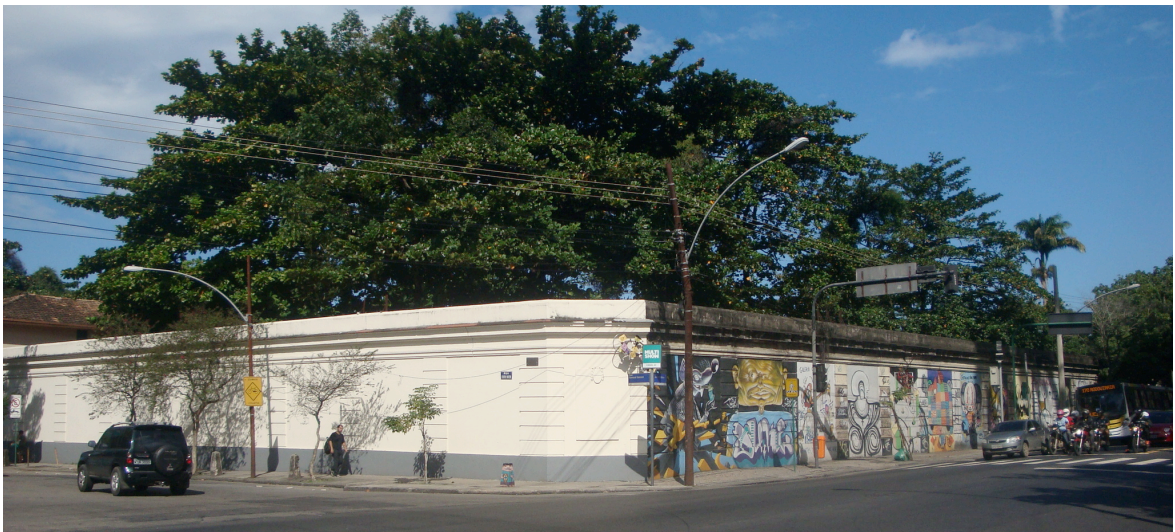
Figura 06: Parte do muro restaurada e parte com os graffiti
