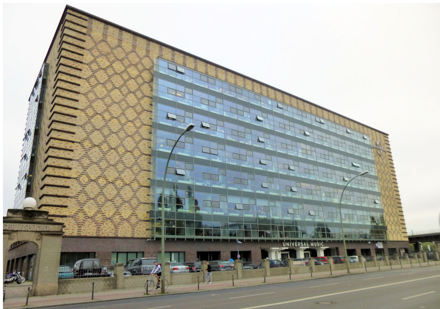
Imagem 02: Sede da empresa Universal Music nas margens do Rio Spree – ocupação pioneira da operação urbana MediaSpree no início dos anos 2000. | Fonte: Arquivo pessoal, 2014.
