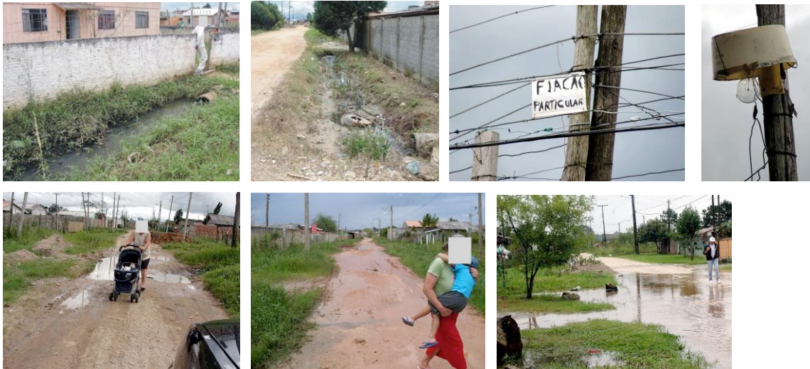
Figura 07: Precariedade urbano-ambiental do Bairro Guarituba. (a, b) valas de esgoto a céu aberto; (c,d) gatos na eletricidade; (e,f) ruas sem pavimentação; (g) ausência de sistema de drenagem.
