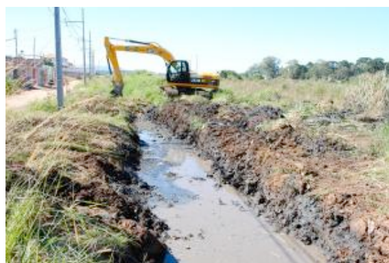
(C) Obras de macro drenagem;
