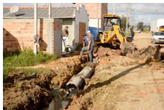
(D) Obras de saneamento.
