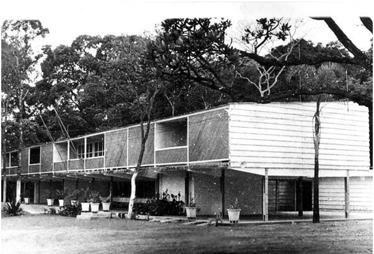
Fig. 3 - O Catetinho, sede presidencial, construído em apenas de 10 dias, projetado por Niemeyer. Fonte: Arquivo Público do DF
