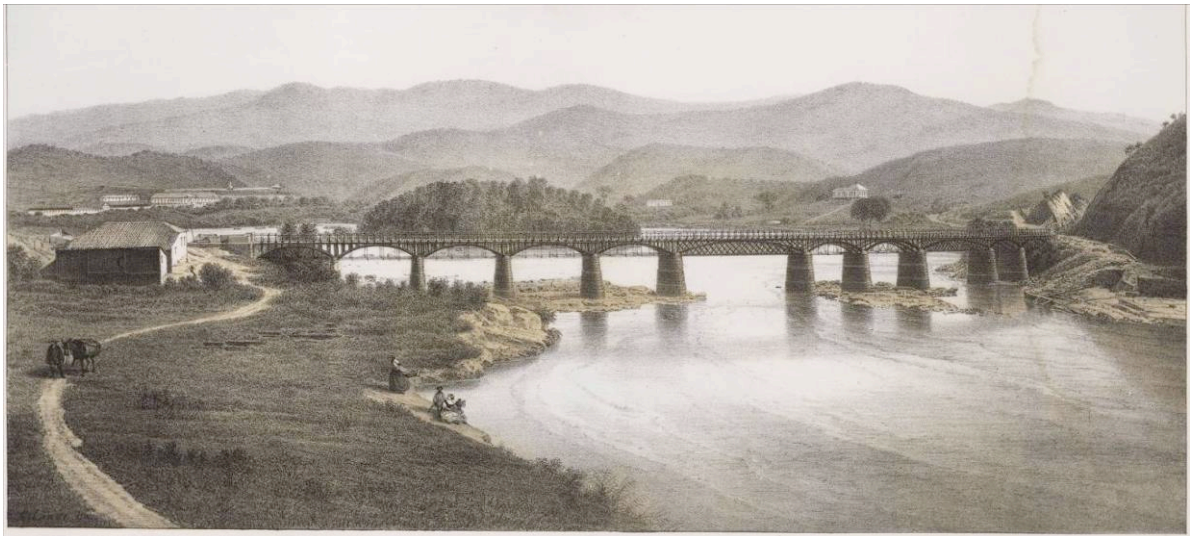
Ponte do Desengano sobre o Rio Parahyba. Linde, Carlos, m. 1873. Acervo: Biblioteca Nacional
