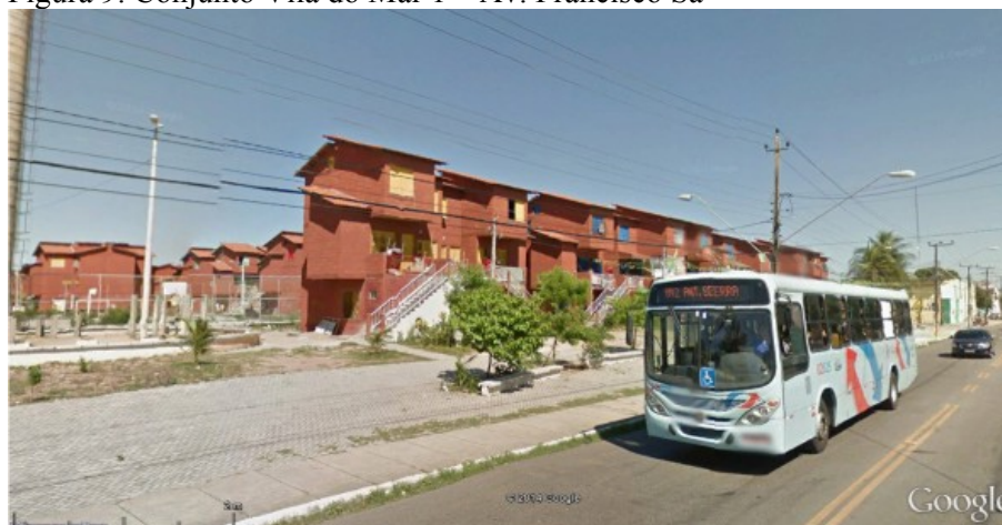
Figura 9. Conjunto Vila do Mar 1 – Av. Francisco Sá
