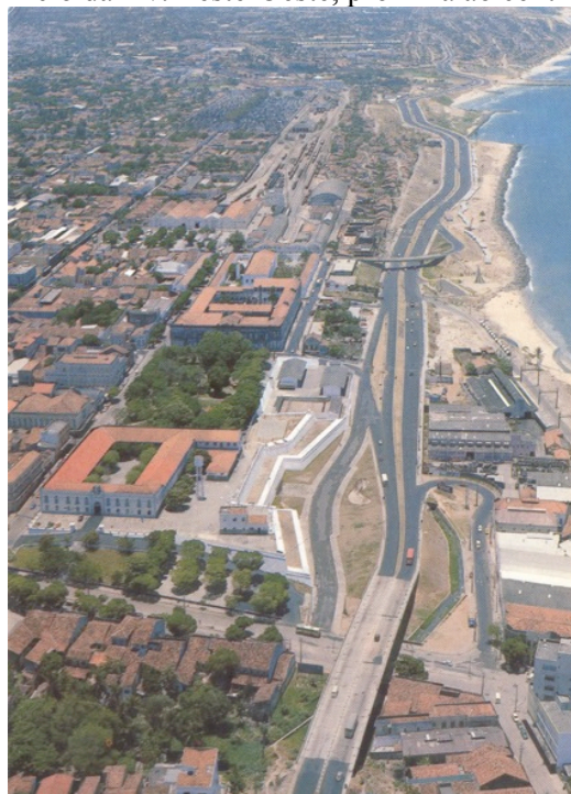
Figura 6. Início da Av. Leste-Oeste, próxima ao centro da cidade
