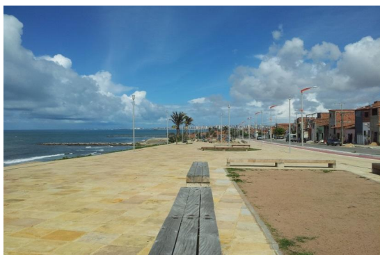
Figura 7. Calçadão Projeto Vila do Mar
