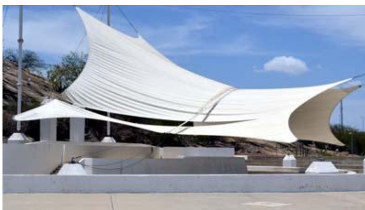
Figura 07: Coberta do anfiteatro da Ilha de Sant'Ana rasgada após forte chuva em fevereiro de 2013
