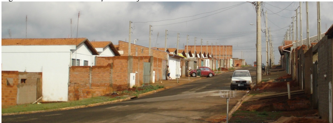
Figura 03 - Falta de arborização no conjunto habitacional Jardim Graminha.
