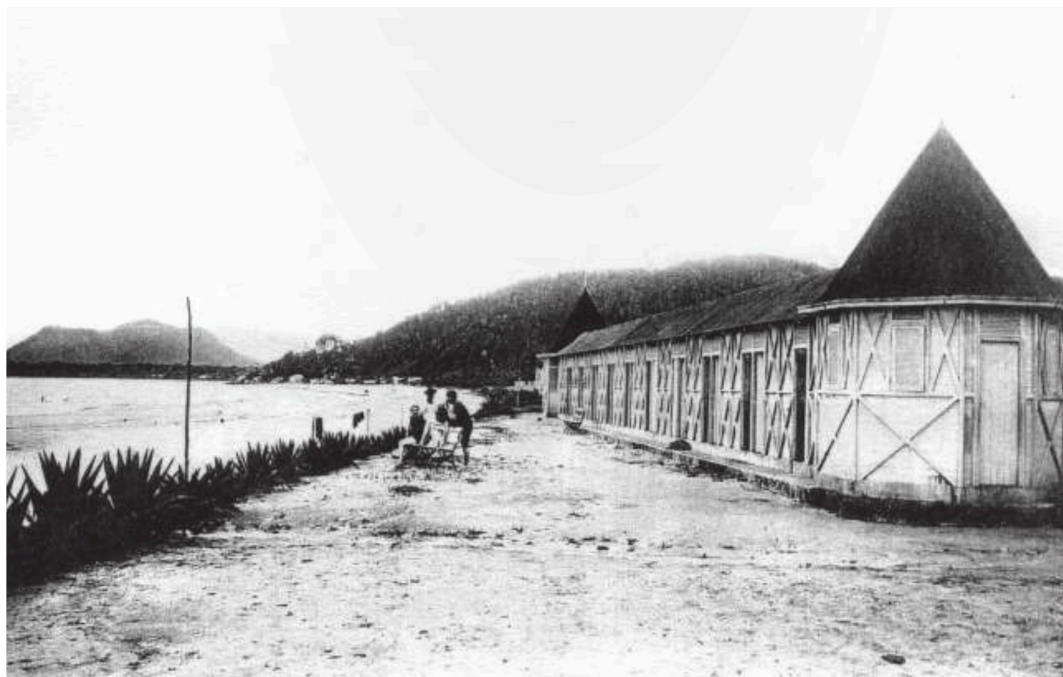
Imagem das cabines de banho instaladas na primeira versão do Hotel. Fonte: acervo pessoal Geraldo Anhaia Mello.
