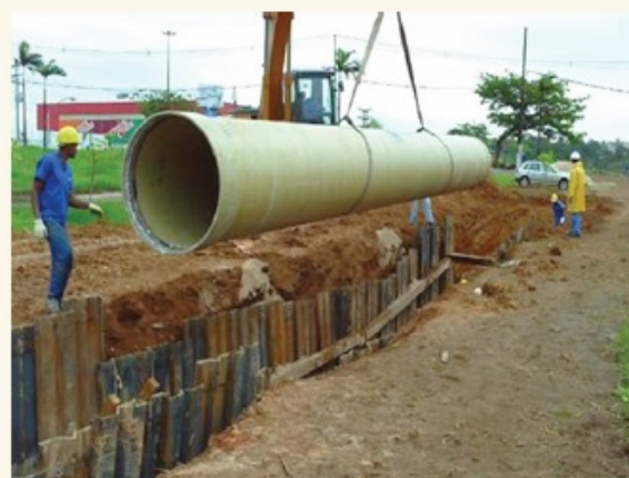
Foto 4 – Assentamento de tubulação Av. Paralela
