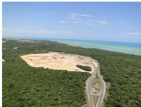
Figura 5. Desmatamento para construção do Centro de Convenções. Fonte: DIEP/SEMAM
