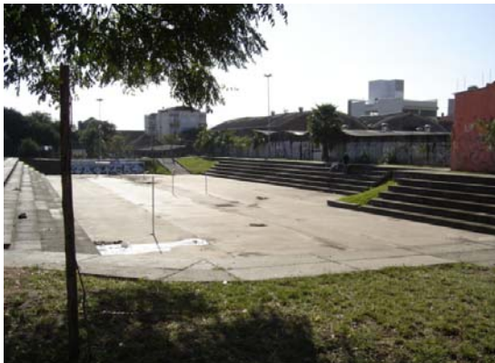
Figura 04: Bacia de detenção, Av. Polônia - Porto Alegre, RS. Fonte: www.portoalegre.rs.gov.br
