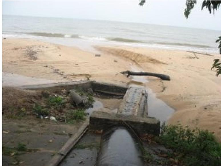
Figura 1: Lançamento de drenagem pluvial na Praia do Chapéu Virado em Mosqueiro.
