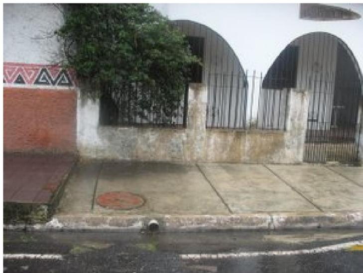
Figura 10: Caixa de ligação de esgoto disponibilizada na frente de lote.
