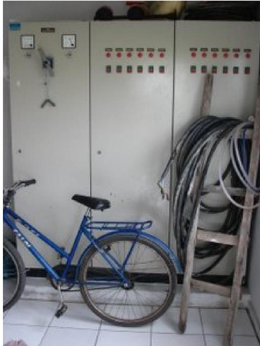
Figura 9: Quadros de comandos elétricos fora de funcionamento.
