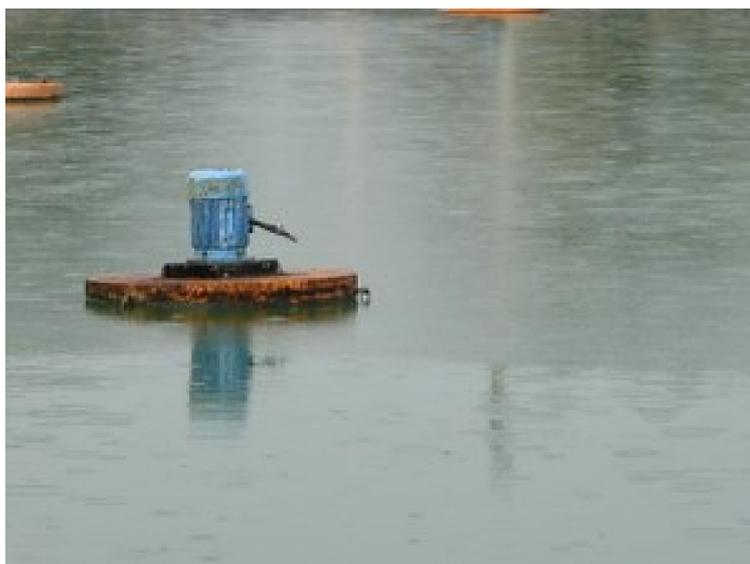
Figura 7: Aeradores não ancorados e não energizados na ETE Aeroporto
