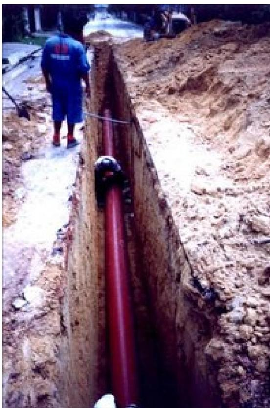
Figura 3: Assentamento de rede coletora na área da Vila.
