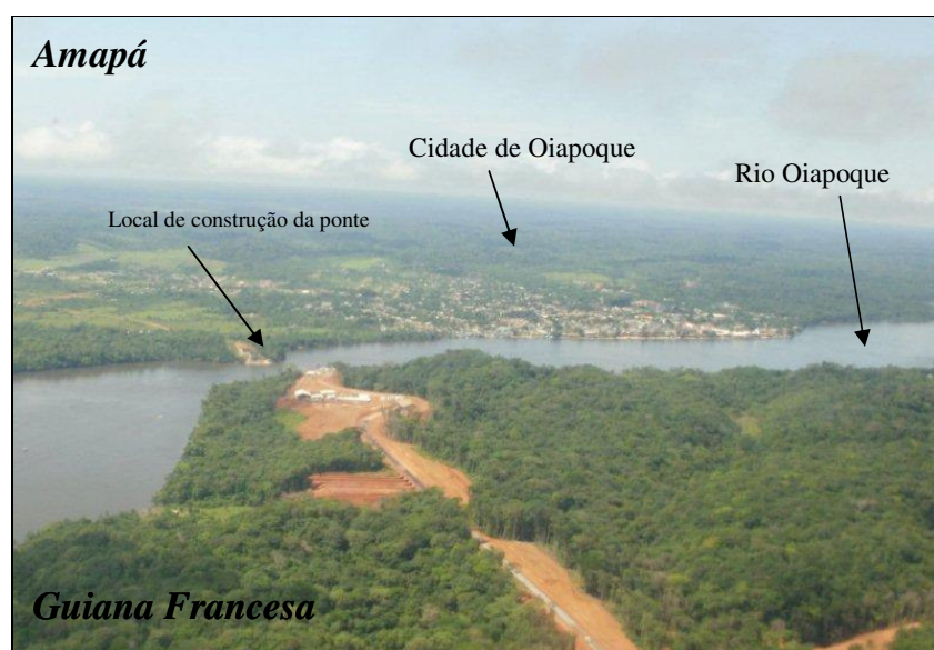
Foto 1 - Local da construção da ponte binacional; cidade de Oiapoque Fonte: Acervo de Stéphane Granger
