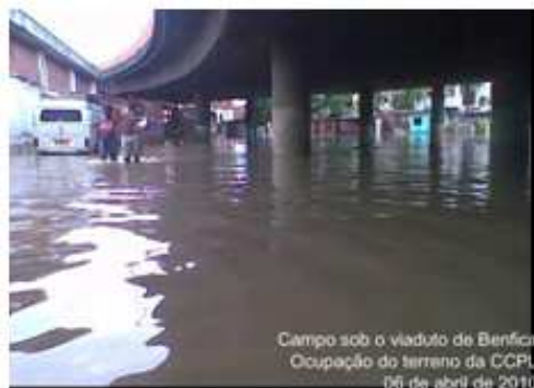
Campo sobre o Viaduto Benfica – 06/04/2010. FONTE: LTM
