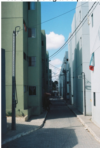
Foto 6 – vista geral do conjunto
