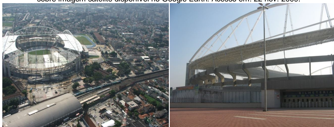
FIGURA 3.3: EOJH ainda em obras frente à estação de trem (esq.). Setor sul das arquibancadas passível de ampliação (dir.). Fotos: Claudia Brack, FPJ (2007); GPDU (2008).
