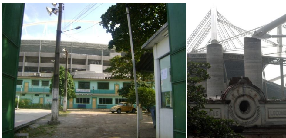
FIGURA 5.2.1: O prédio que seria demolido com a construção do EOJH (esq.) e fachada da Oficina de Locomoção do Engenho de Dentro em processo de deterioração (dir.). Fotos: GPDU (2010).
