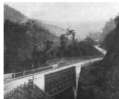
Fig. 7: Trecho da Rodovia Companhia União e Indústria. Fonte: TRIBUNA de Minas, 1997.
