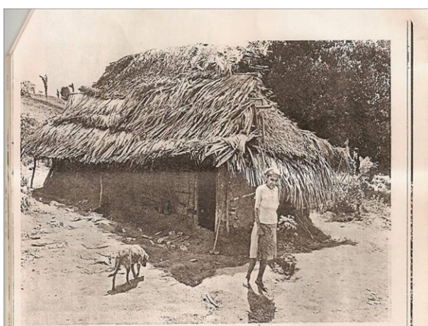
FOTOGRAFIA 1 – Sapezinho: casa construída de adobe e telhado de palha. Fonte: Rodrigues (1980, p. 63).
