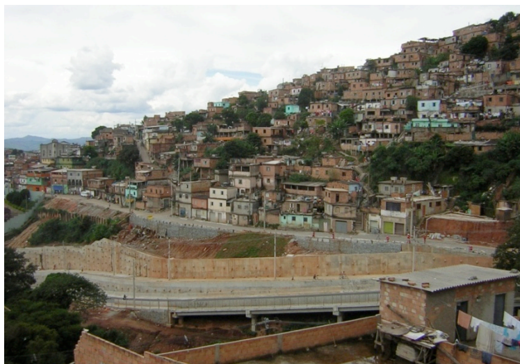
Figura 01: Vista da Av. do Cardoso, na Vila Nossa Senhora de Fátima Fonte: acervo próprio
