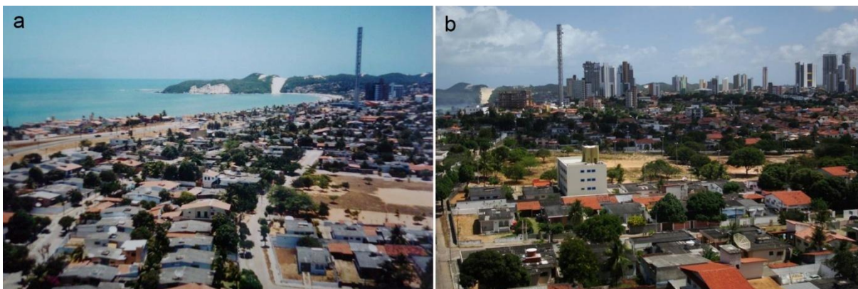
Figura 2. a) Vista de Ponta Negra do edifício Corais do Atlântico, 2000. b) Vista de Ponta Negra (skyline) do edifício Corais do Atlântico, 2008.
