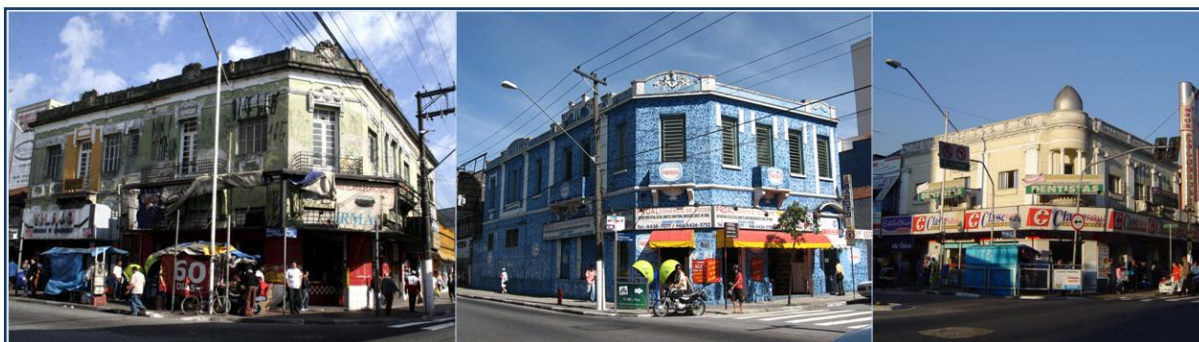
Ilustração 02. Sobrados originalmente de uso misto nas proximidades da estação ferroviária, área mais valorizada para a instalação comercial (2007).
