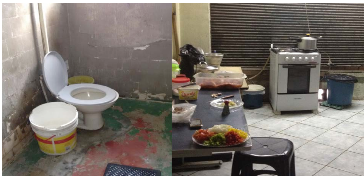
Figura 2 – Imagens de banheiro e cozinha coletivos de cortiço na
