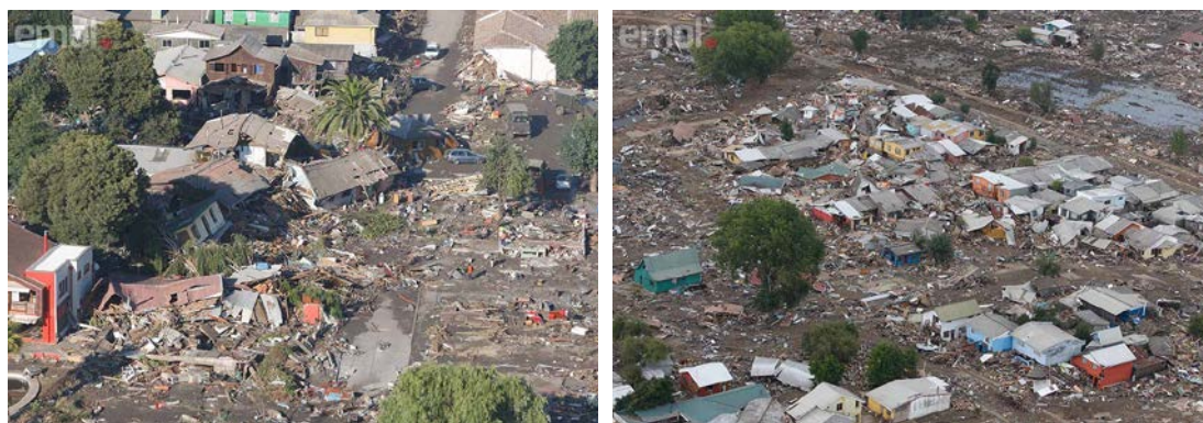
Figura 4 – Destruição causada pelo terremoto e tsunami em Constitución, 2010. Fonte: Emol, 2016.
