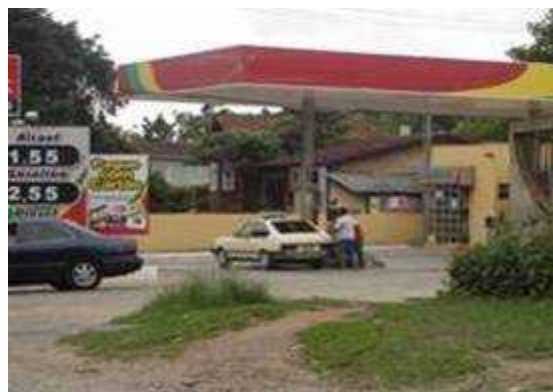
Figura 9 – Posto de combustível localizado na região das nascentes do Rio Belém (Ponto B)
