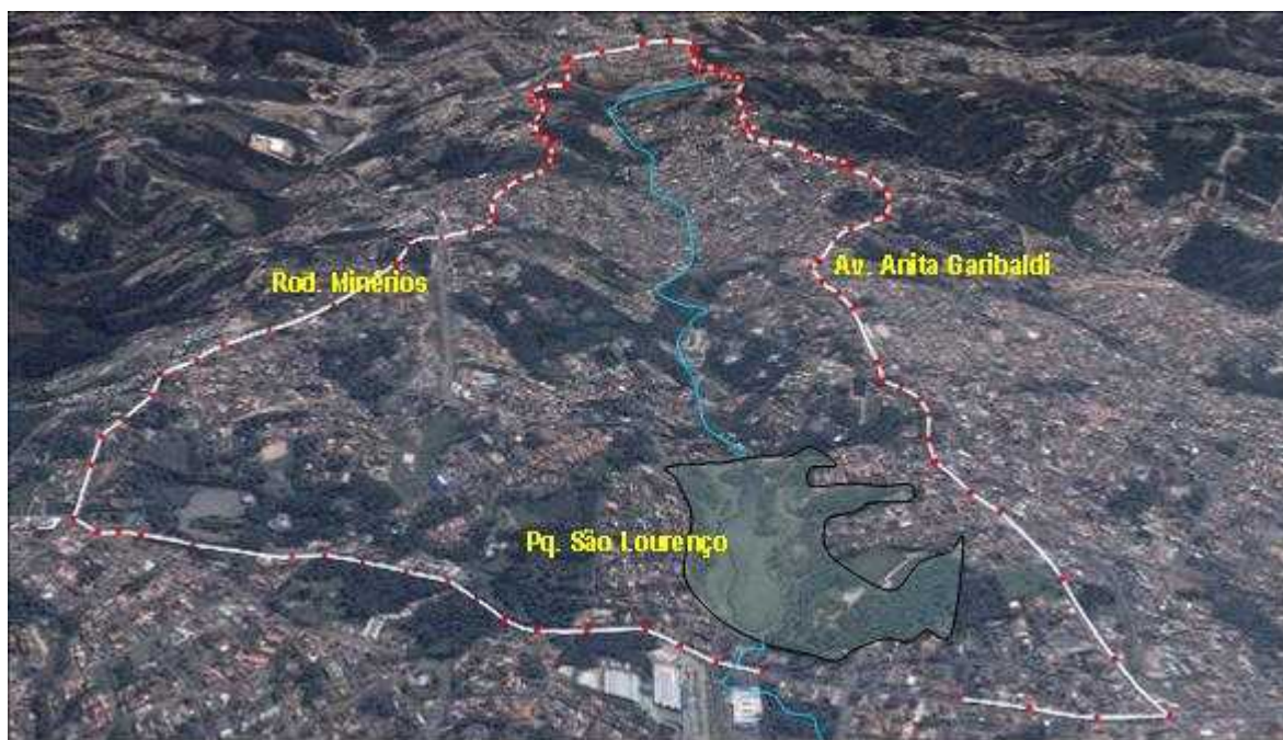
Figura 10 – Vista da área de estudo, enfocando a ocupação urbana generalizada.
