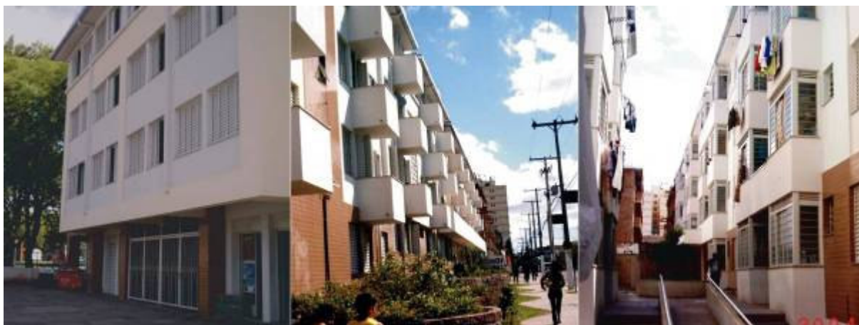
Figura 1 – conjunto habitacional Princesa Isabel: vistas externas e internas
