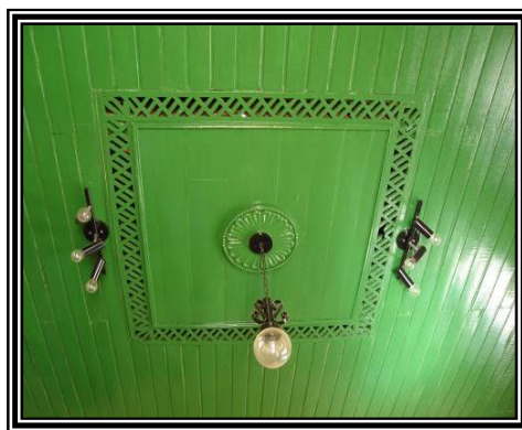
Figura 13 – Detalhe do Forro em tabuado. Fonte: Neuza Melo, 2006.
