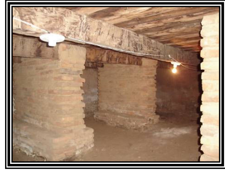
Figura 5 – Pilares no porão do Edifício. Fonte: Neuza Melo, 2006.
