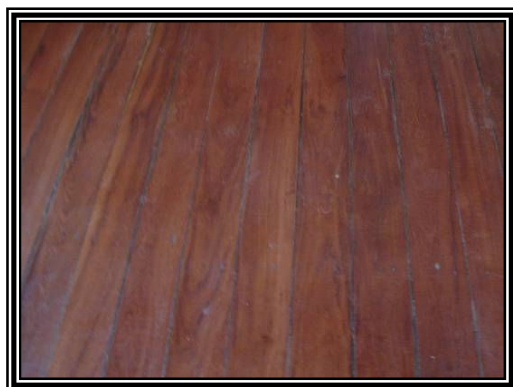
Figura 11 – Detalhe do Tabuado Corrido. Fonte: Neuza Melo, 2006.
