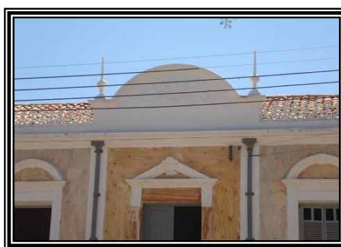
Fig. 9. Detalhe da Platibanda. Fonte: Neuza Melo, 2006.
