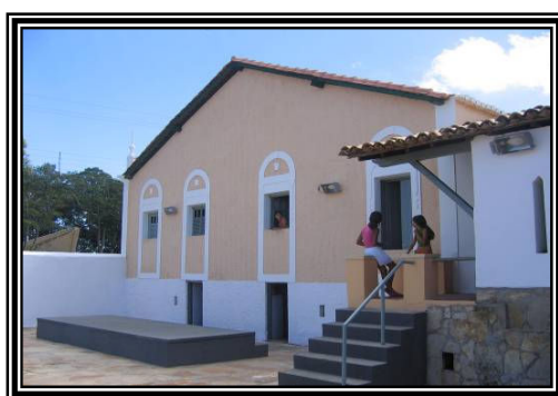
Fig. 8. Detalhe da Empena, Telhas e uso da argamassa. Fonte: Neuza Melo, 2006.
