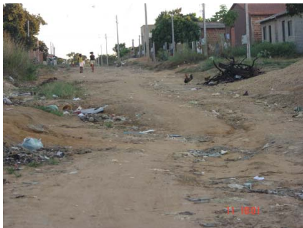
Figura 2 – Via sem Pavimentação Asfáltica no Setor Santa Fé (Palmas Sul)
