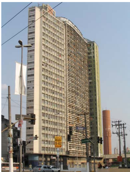
Figura 2: Edifício São Vito. Foto do autor, 2005.
