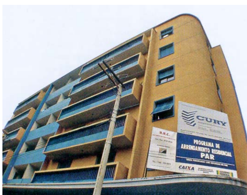
Figura 1: Edifício Fernão Salles (PAR). Foto do autor, 2005.
