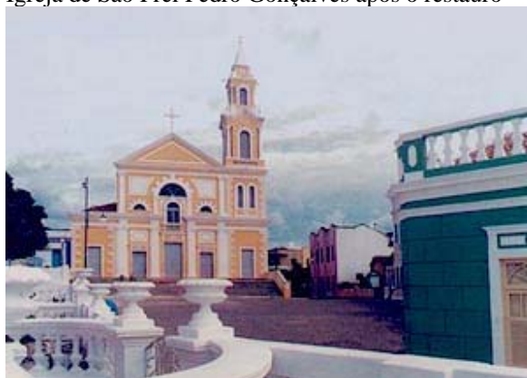
Fig. 21. Largo de São Frei Pedro Gonçalves. Vista da Igreja de São Frei Pedro Gonçalves após o restauro
