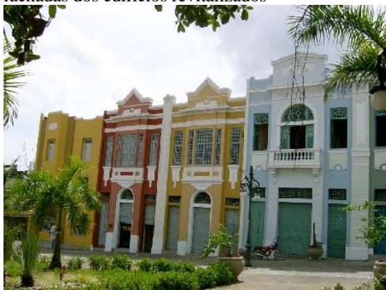
Fig. 20. Praça Anthenor Navarro. Vista das fachadas dos edifícios revitalizados
